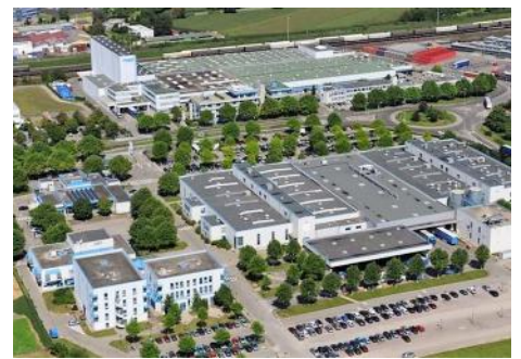
Usine Hager Electro d'Obernai
